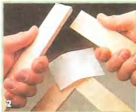
2 Вертикальные и горизонтальные детали рамы соединяют встык на клею. Вторую половинку собирают по образцу уже готовой
