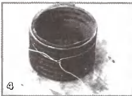
Фото 3, 4. Опалубка для «шляпки». Чтобы ее сделать, понадобятся обрезок широкой доски, резиновый коврик и горсть гвоздей
