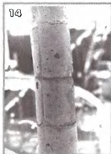
Фото 13, 14. Опалубка разрезана и снята с фундамента. Остается затереть раковины и бороздки на поверхности ножки
