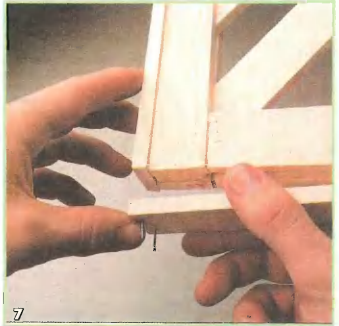
Установка контурных декоративных планок. Сначала крепят горизонтальные элементы, а затем — вертикальные
