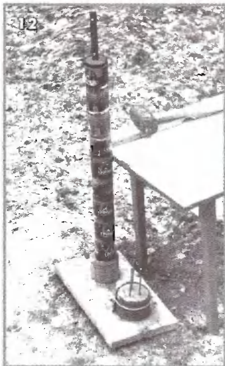
Фото 12. Заливка «ножки». В верхнюю ее часть вмурован обрезок уголка для соединения фундамента со стойкой забора
