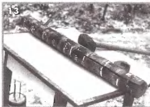
Фото 13, 14. Опалубка разрезана и снята с фундамента. Остается затереть раковины и бороздки на поверхности ножки
