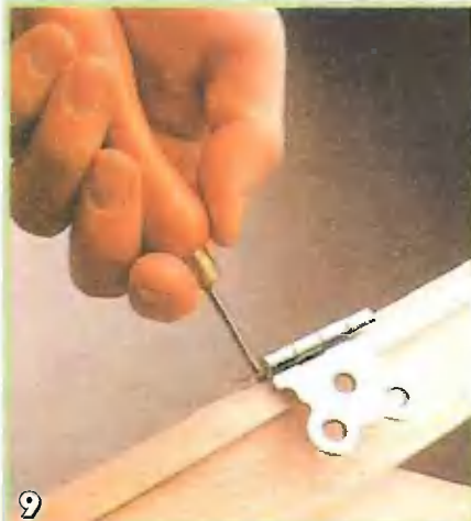
Декоративные петли приворачивают к секции шурупами-саморезами
